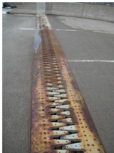
Junta de dilatação de uma ponte.
