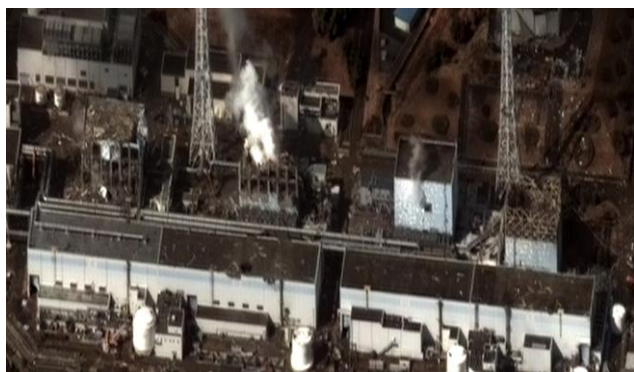
Imagem de 16 de março de 2011 dos quatro prédios dos reatores danificados. Da direita para a esquerda: Unidades 1, 2, 3 e 4.
