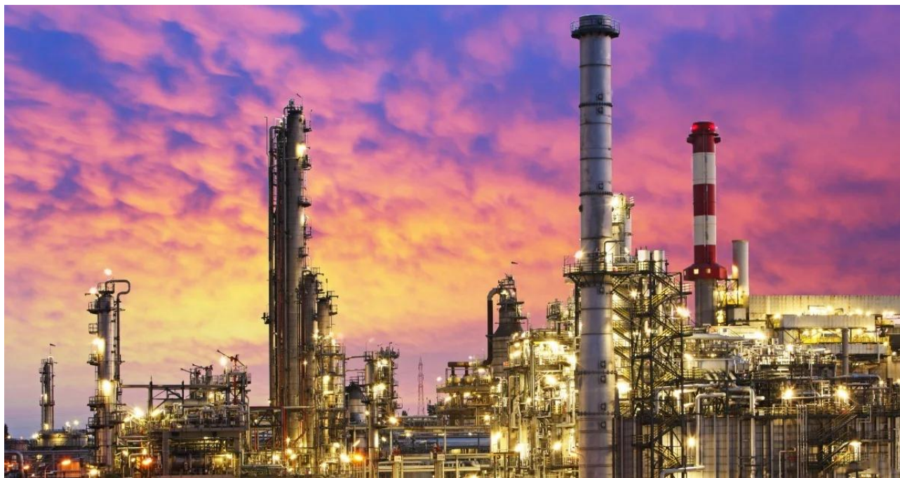
Fotografia de uma refinaria de petróleo. Estas grandes chaminés são as colunas de fracionamento.
