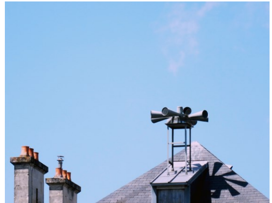
Uma sirene, no telhado de uma fábrica?
