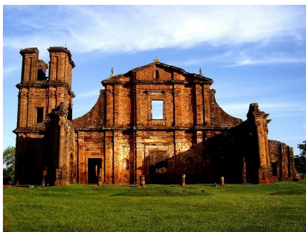
Ruínas de São Miguel
