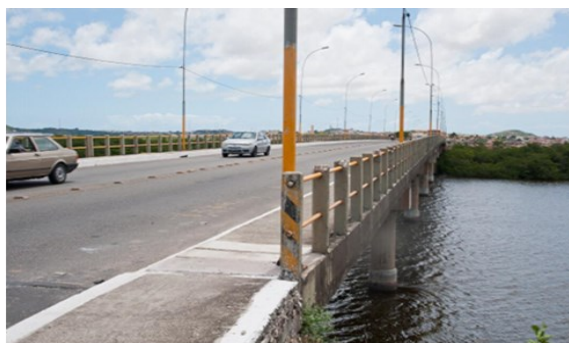
Ponte que funciona como limite entre as cidades de Aracaju e Socorro.
