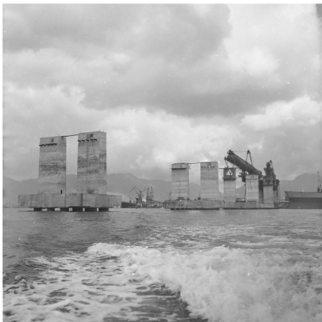
Construção da Ponte Rio-Niterói, 1971
